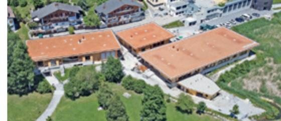
Das neue Gebäude der erweiterten Schulanlage in Laax erhielt eine Dachabdichtung aus «ökologischem Kunststoff». Diese erfüllt den Minergie-Eco-Standard und ist eine klimafreundliche Alternative zu Bitumen. (Bild: Sika Schweiz AG)
