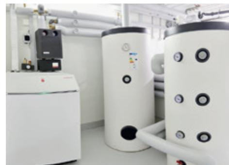
▲ Die komplette Anlage inklusive Pufferspeicher und Warmwasserspeicher versorgt im Einfamilienhaus alles, und zwar vom Heizkörper bis zur Fussbodenheizung.
