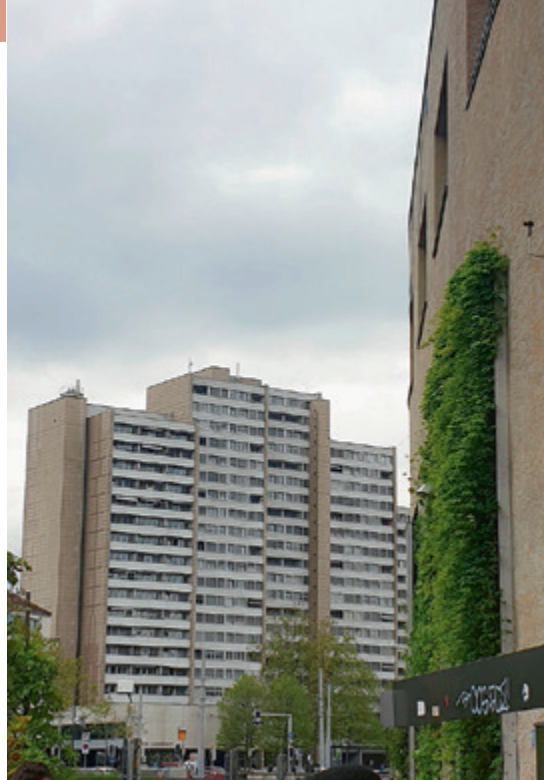
Lochergut, Stadt Zürich (in den 1960er-Jahren erbaut); inventarisiert.
