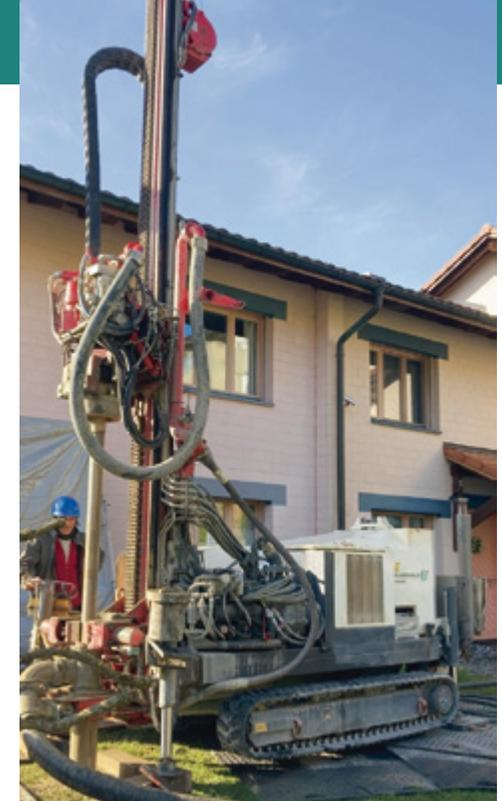
Kleinstes Bohrgerät der Schweiz: Dank dem kleinen Bohrgerät bohren die Profis zudem kostengünstig Erdwärmesonden – auch dort, wo andere Unternehmen das nicht mehr schaffen. Somit lassen sich die effizienten Wärmepumpen der Grünenwald AG an zusätzlichen Standorten sinnvoll nutzen. Die Abmessungen des Bohrgeräts sind auf der Firmen-Website abrufbar.
