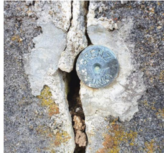
Messingbolzen: Runder Metallbolzen (meist Messing) mit Prägung «Grenzpunkt/GP», verwendet in Asphalt, Pflaster oder Mauerwerk.
