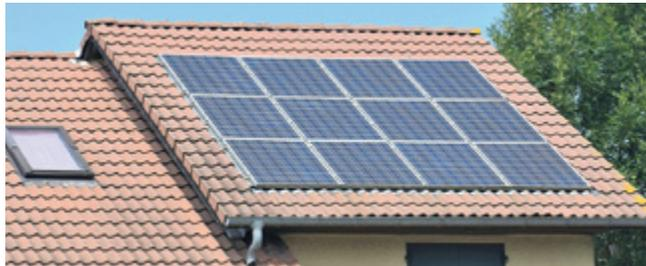
Eine Photovoltaikanlage (PV-Anlage) wandelt Sonnenlicht direkt in elektrische Energie um, um Strom zu erzeugen. Die erzeugte Energie kann entweder direkt im Haushalt genutzt, in einem Batteriespeicher gespeichert oder in das öffentliche Stromnetz eingespeist und vergütet werden.
