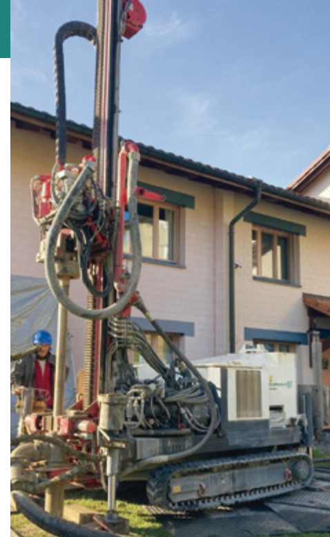
Kleinstes Bohrgerät der Schweiz: Dank dem kleinen Bohrgerät bohren die Profis zudem kostengünstig Erdwärmesonden – auch dort, wo andere Unternehmen das nicht mehr schaffen. Somit lassen sich die effizienten Wärmepumpen der Grünenwald AG an zusätzlichen Standorten sinnvoll nutzen. Die Abmessungen des Bohrgeräts sind auf der Firmen-Website abrufbar.
